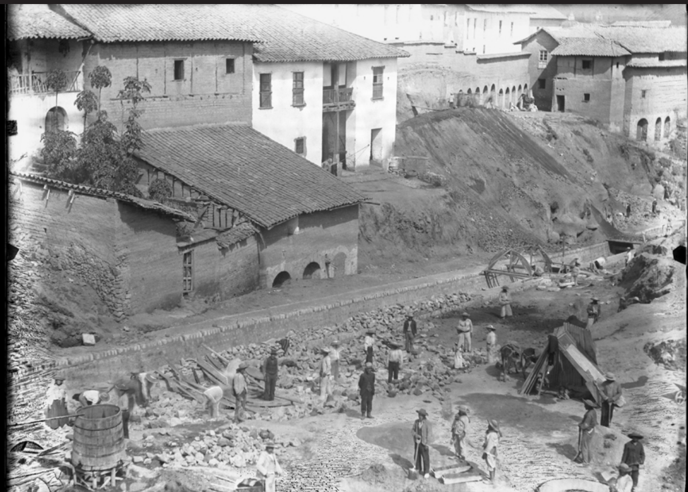
Sector de la Capilla del Robo en proceso de canalización y relleno. Fotógrafo desconocido, hacia 1905.
