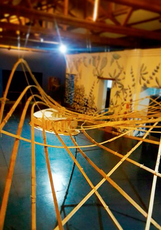
Los materiales que normalmente se utilizan para este tipo de estructuras son compuestos de fibra de vidrio y/o carbono, en Ecuador se buscará priorizar el uso del bambú, por su fuerte presencia como material local.
